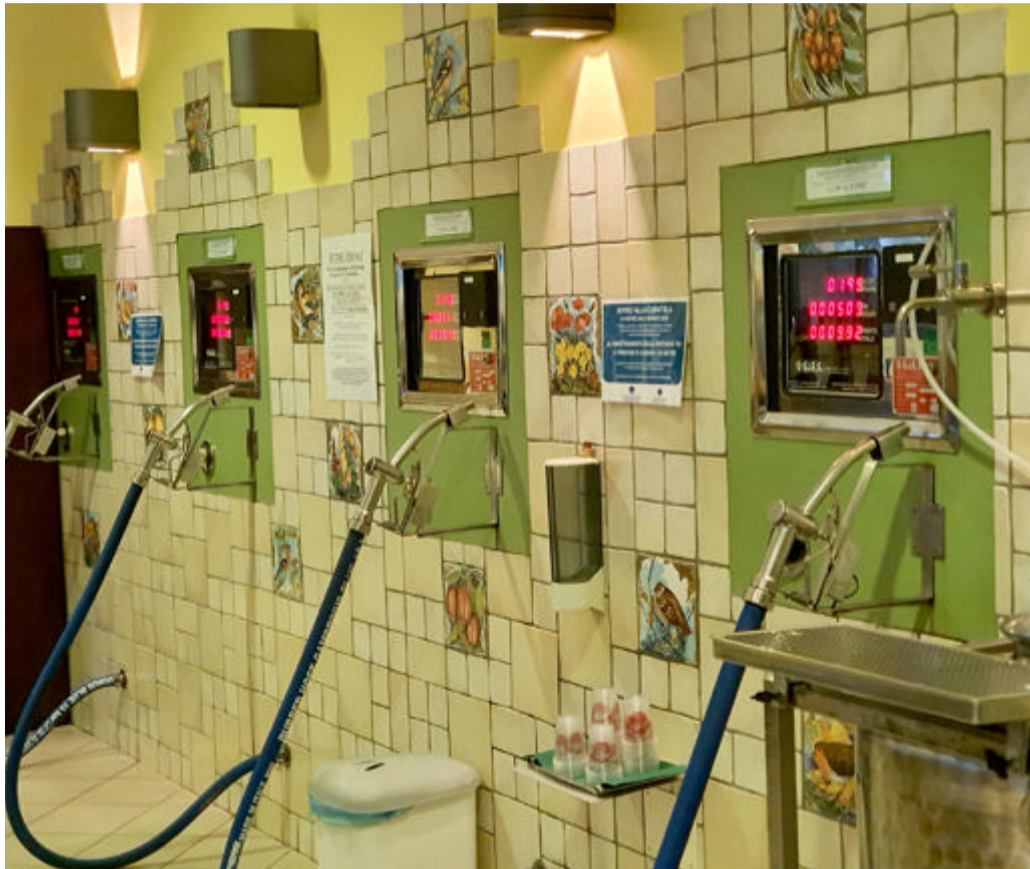
▲ Im Unternehmenssitz von Terra di Brisighella gibt es die Möglichkeit, sich vor allem Wein analog einer Tankstelle abfüllen zu lassen.
